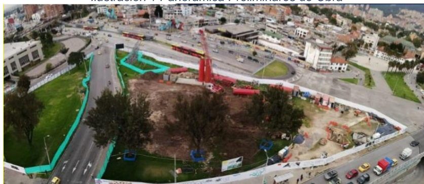
Ilustración 1 Panorámica Preliminares de Obra
