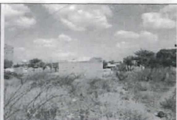
En esta imagen podemos ver el deterioro en el que se encuentra el área construida.
