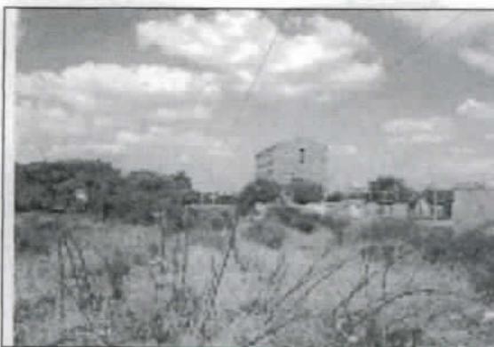
En esta imagen podemos apreciar el grado de peligrosidad que tiene el predio por los cables de alta tensión que pasan por el mismo
