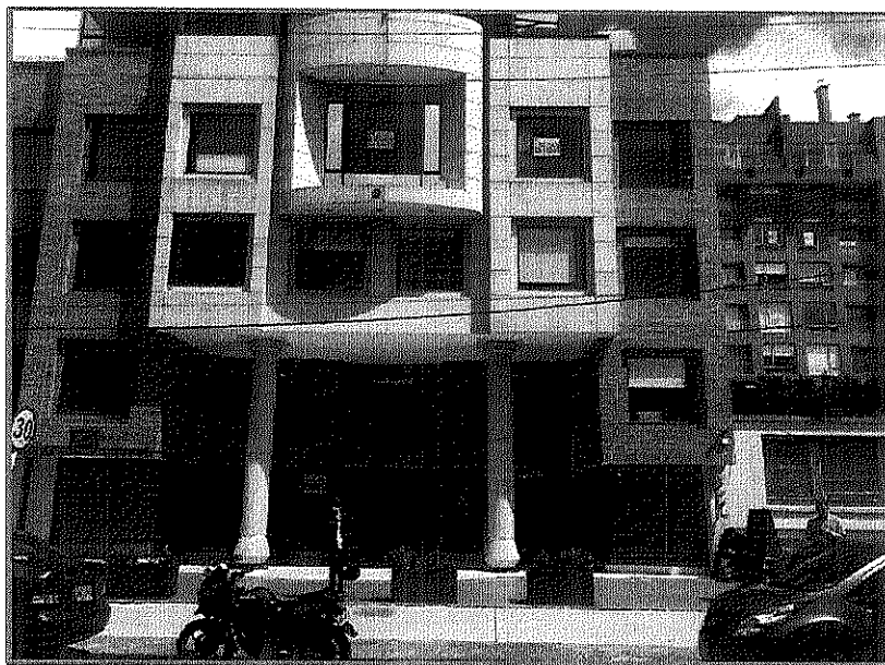
Fotografía No. 3 Fachada edificio Inverpor oficina Chico.
