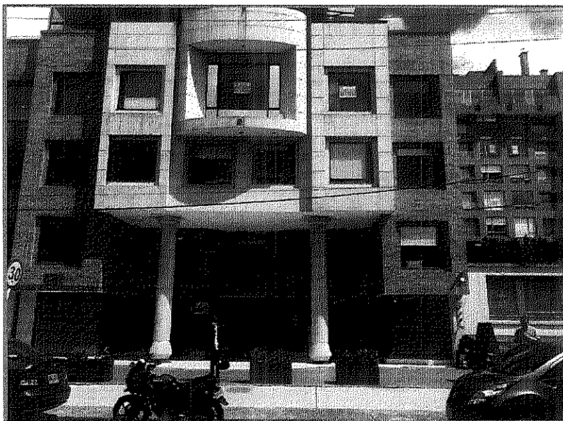
Fotografía No. 3 Fachada edificio Inverpor oficina Chico.
