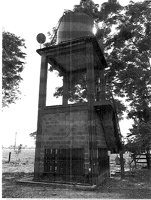
Fotografía No.4 Tanque de almacenamiento y planta eléctrica.
