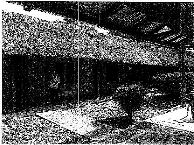
Fotografía No.5. construcción alojamiento empleados.
