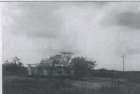
Casa del Predio PROVIDENCIA
