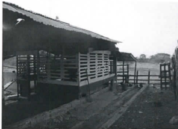
Casa Principal buen estado
