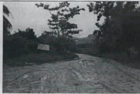
Vía Tierralta – Mi Refugio,, punto conocido como la Y, vía a la derecha
